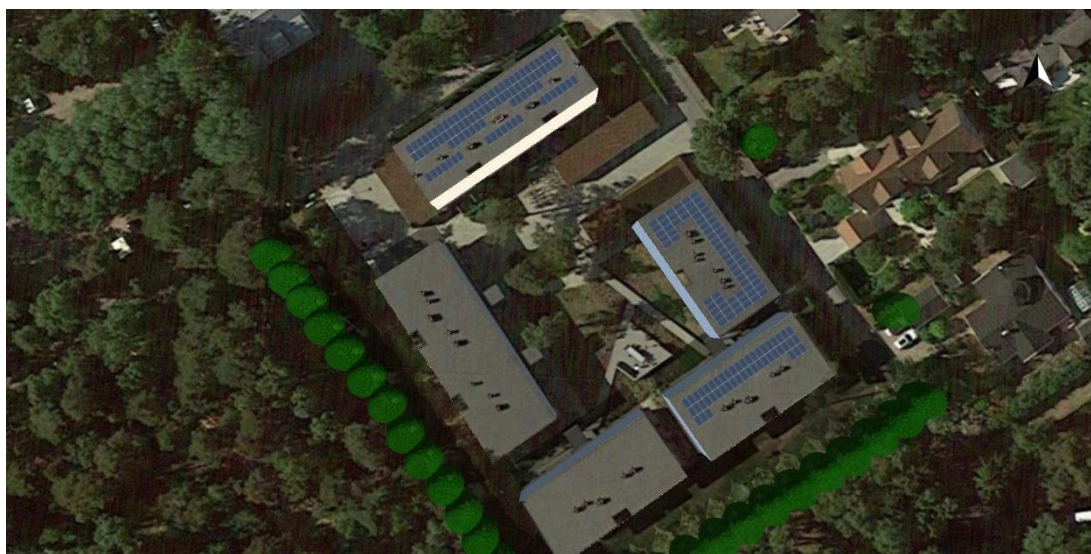
Bild 4. Projekterad solcellsinstallation på Brf Vita Stränder.
